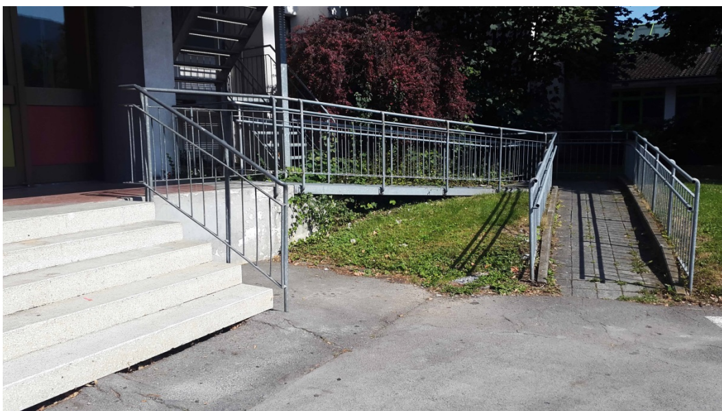
Abbildung 23: Rampe zum Eingangsbereich Proton – das freie Radio
